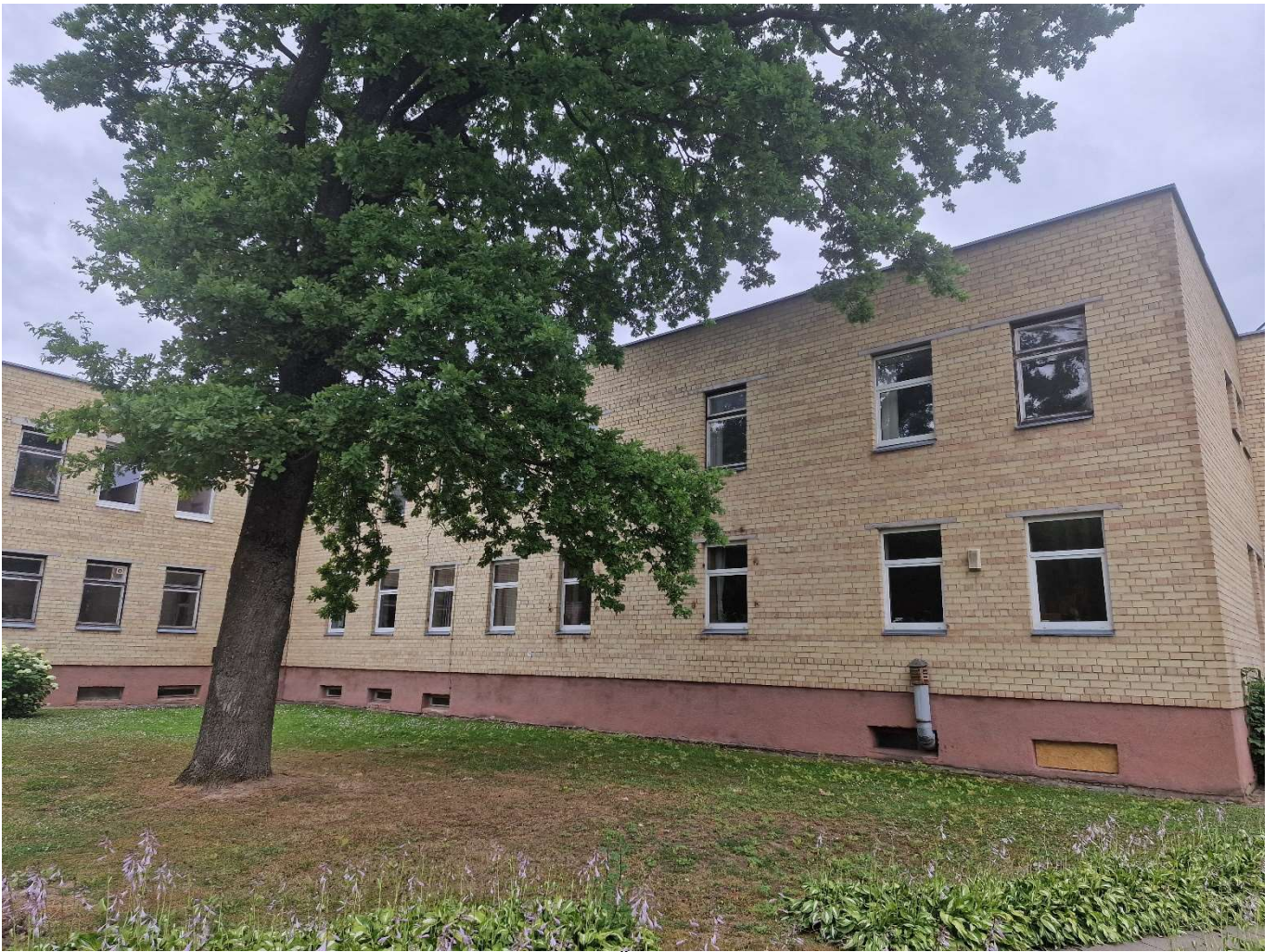
3. Pav. Šiaurinis fasadas
