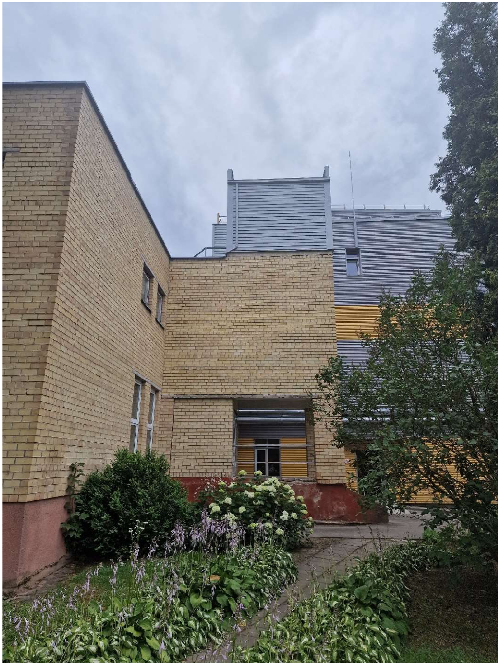
2. Pav. Šiaurinis fasadas
